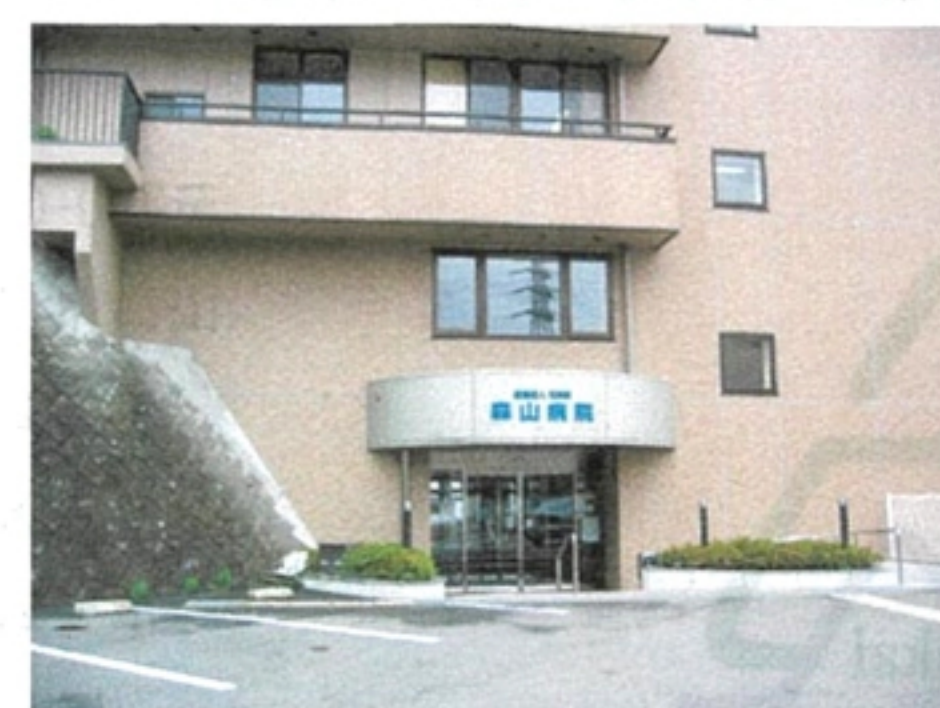
3 F 入院棟（新館）駐車場・玄関
